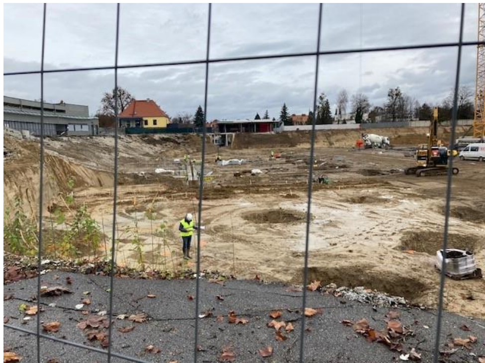
Abbildung 2: Baustelle „LASK-Arena“ am 2.12.2021 (im Hintergrund links und mittig Gebäudeteile der alten Stadionanlage)
